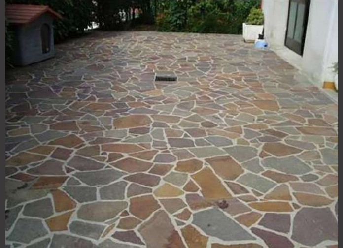
RISKANTE PORPHYRPFLASTERARBEITEN
