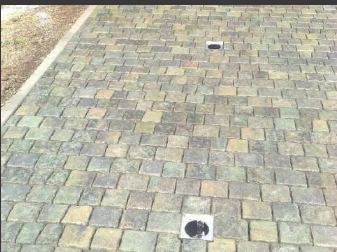
SELBSTSICHERNDER TROMMELSTEINBLOCK
