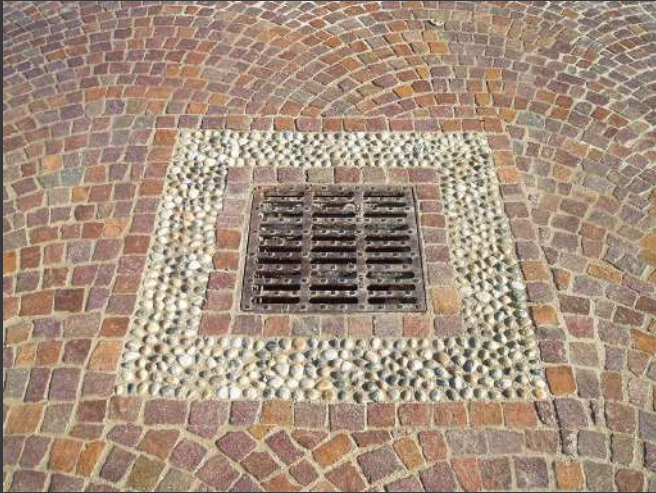
STEIN-DRAINAGERAHMEN FÜR BODENBELÄGE
