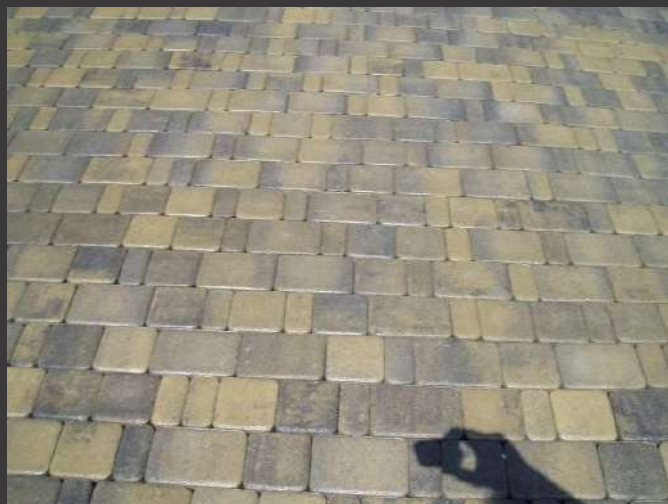
MODÈLE RUSTIQUE AUTOBLOQUANT DOTÉ D'UNE PROTECTION CONTRE L'USURE.
