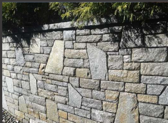
MUR DE SOUTÈNEMENT EN PIERRE COMPOSITE DE LUSERNA
