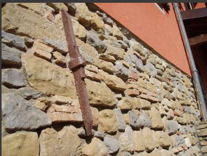
MUR DE SOUTÈNEMENT EN PIERRE DE MOLERA.
