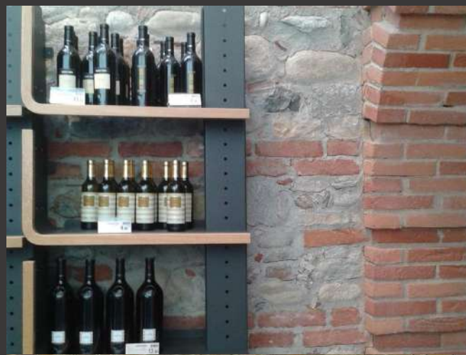
BARDAGE VERTICAL EN BRIQUES ET GALETS
