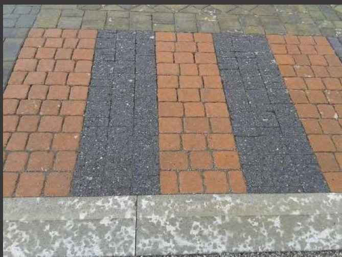
REVÊTEMENTS DE CHAUSSÉE ANTIDÉRAPANTS AVEC SYSTÈME AUTOBLOQUANT
