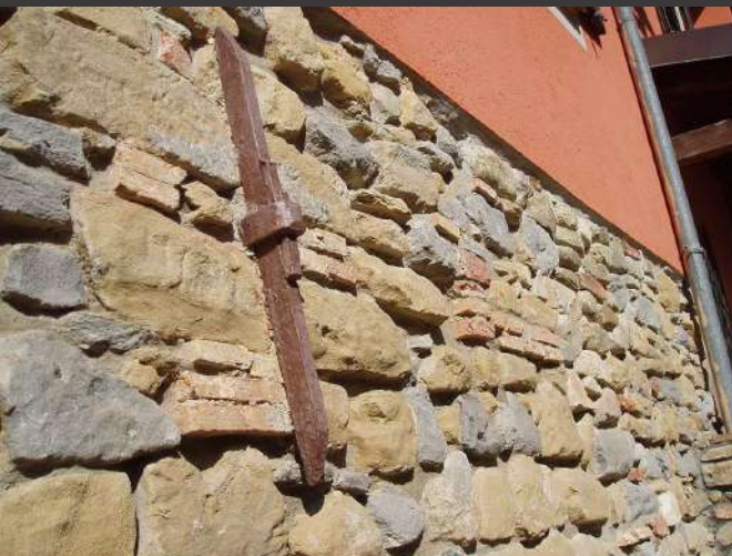
MURO DI CONTENIMENTO IN PIETRA DI MOLERA
