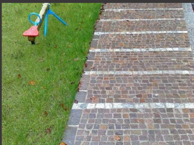
CUBETTI DI PORFIDO DISPOSTI IN FILE PARALLELE
