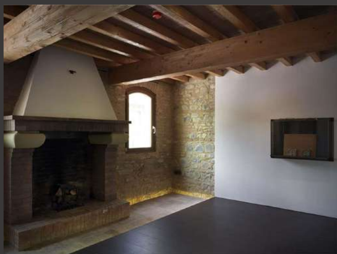
RIVESTIMENTO CAMINO CON PIETRA LOCALE
