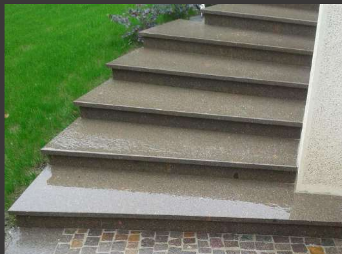
GRADINI IN PORFIDO FIAMMATO
