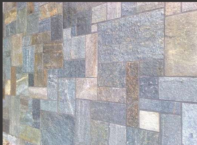
PAVIMENTO DI LUSERNA STUCCATO
