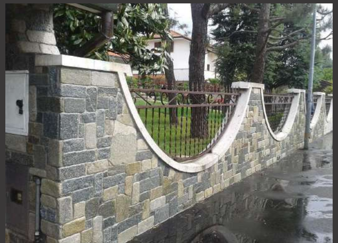
RECINZIONE IN PIETRA DI LUSERNA MISTA
