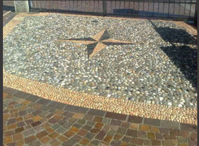
PARTICOLARE INGRESSO CARRABILE IN CIOTTOLI
