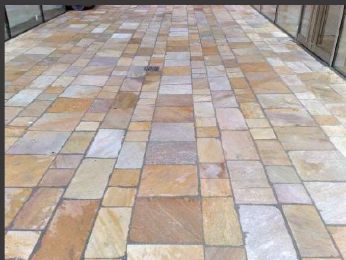
VIALETTO IN PIASTRELLE DI QUARZITE
