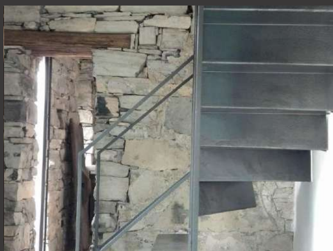
RIVESTIMENTO VERTICALE PORTANTE IN PIETRA
