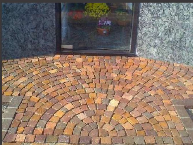
PAVIMENTO PER UNA CAPPELLA MONUMENTALE
