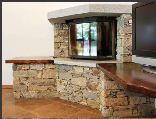
RIVESTIMENTO BASAMENTO CAMINO CON PIETRA
