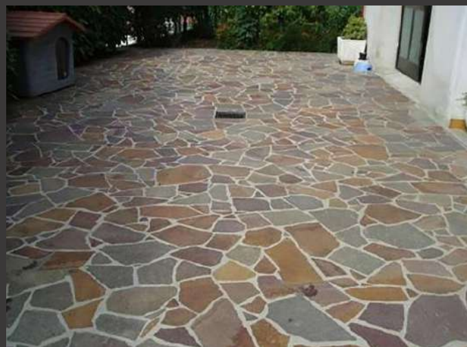
LAVORI DI PAVIMENTAZIONE PERICOLOSI IN PORFIDO
