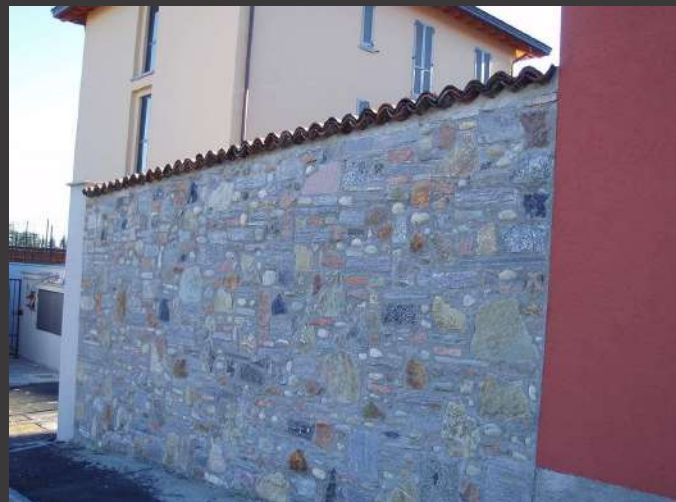
MURO MISTO IN PIETRA LOCALE
