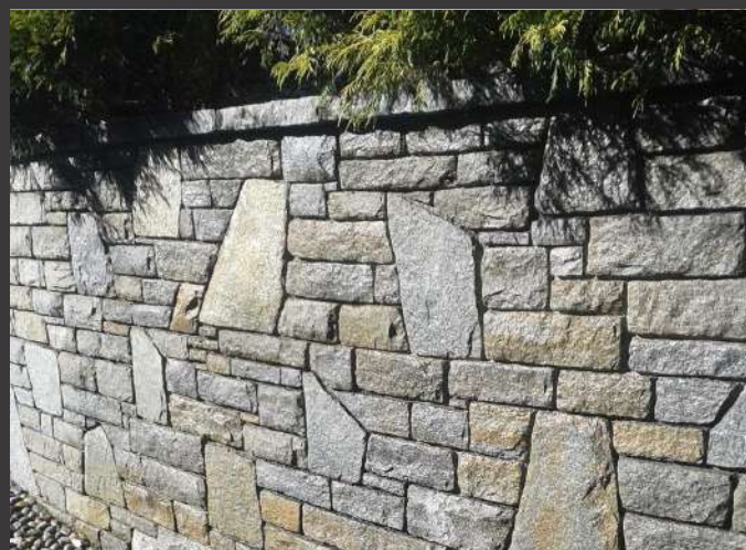
MURO DI CONTENIMENTO IN PIETRA MISTA DI LUSERNA
