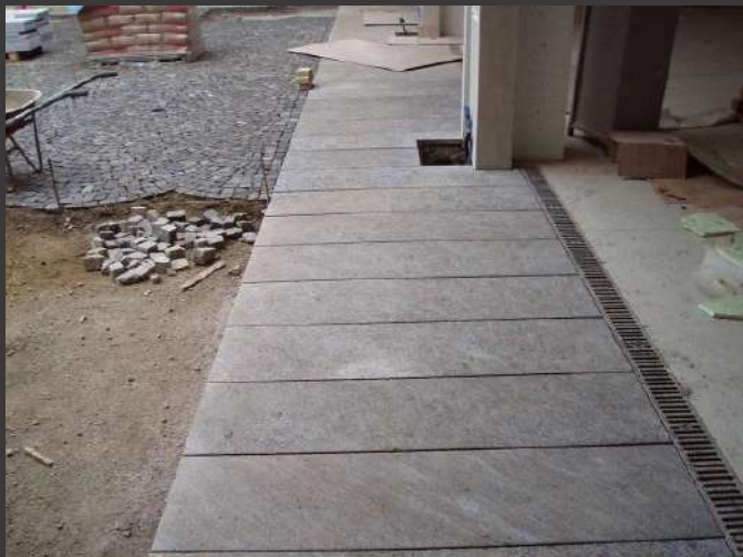
PASSERELLA IN LASTRE DI BEOLA SABBIAIE
