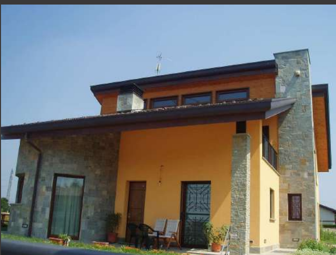
RIVESTIMENTO DI FACCIATA IN PIETRA DI LUSERNA
