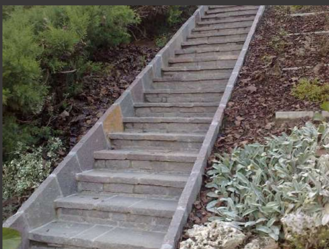
SCALA IN LASTRE DI PORFIDO
