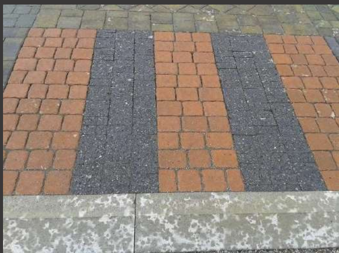
CARREGGiate ANTIDRUCIOLO CON AUTOBLOCCANTE
