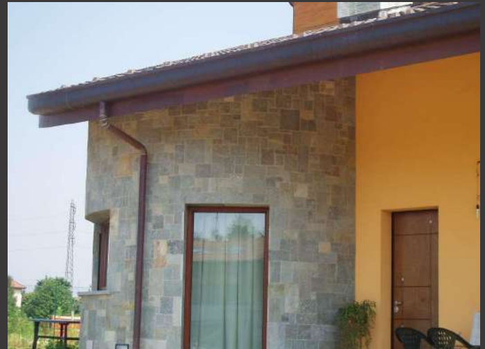
RIVESTIMENTO TORRE IN PIETRA
