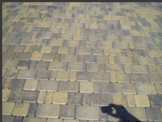
MODELLO RUSTICO AUTOBLOCCANTE CON PROTEZIONE ANTIUSURA
