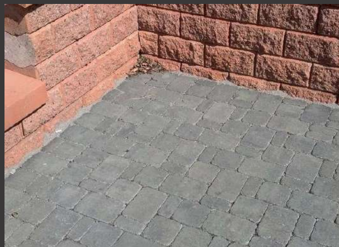
MURETTO CONTENIMENTO SUPERFICIE SPLITTATA
